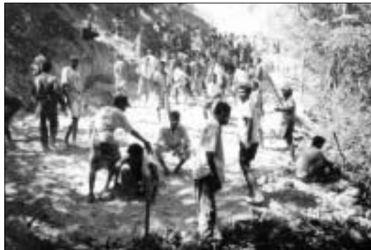
PANTANG PULANG: Selama 4 hari berturut-turut warga bergotong-royong di lokasi yang telah ditetapkan. Mereka tidak pulang ke rumah, tetapi tinggal di tenda-tenda.
